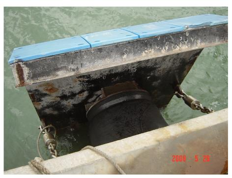
Shenzhen Shekou Container Terminal (SCT) 深圳蛇口集装箱码头 A 2 years old China made fender, paint got thinner and rusted! 一个中国制护舷于使用两年后防冲板油漆出现稀薄及锈蚀情况! (资料提供:蛇口集装箱码头有限公司陈瑞滨先生)
