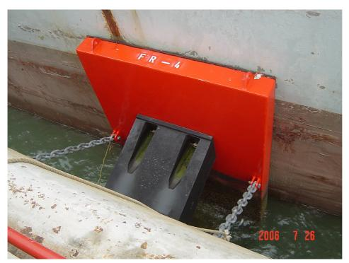
Aviation Fuel Supply Company Sha Chau Plant 香港航煤供应营运有限公司 In 2006, 8 nos. of Trellex fender Panel was sandblasted, re-painted and re-installed 在香港航煤供应营运有限公司的"定期更换护舷计划"下,总共八个 Trellex 厂制之防冲板 经喷沙、再喷油漆后装回再用。(资料提供:香港航煤供应营运有限公司李国基先生)
